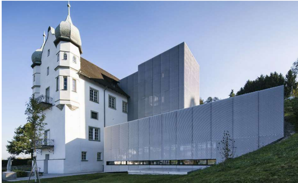
Замок Хофен – реконструкция
