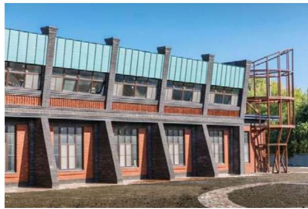
Реновация заброшенной фабрики под частный жилой комплекс для компании «АМИЛКО» в городе Миллерово
