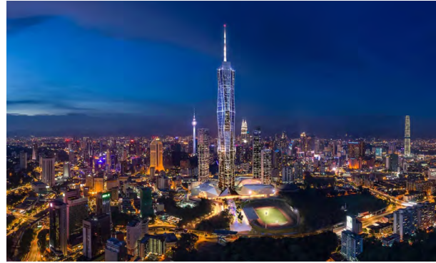
Небоскреб Merdeka 118 in Kuala Lumpur, Малайзия / Fender Katsalidis
