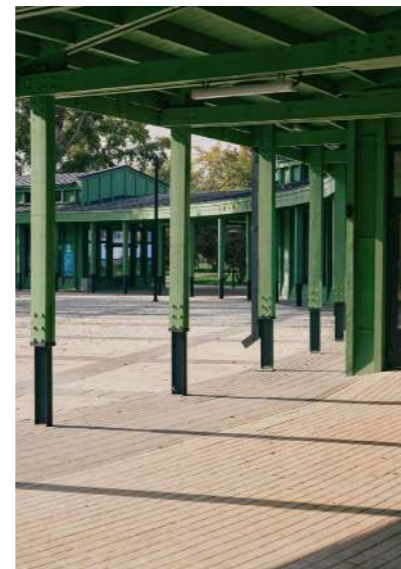
Элементы несущего каркаса открыты и выполняют в том числе декоративную функцию, формируют ритмичную пластику фасадов
