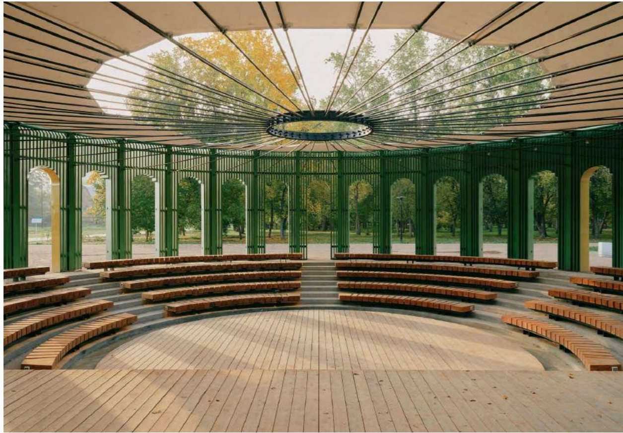
Внутреннее пространство заглублено ниже отметки окружающего ландшафта и перекрыто тентом
