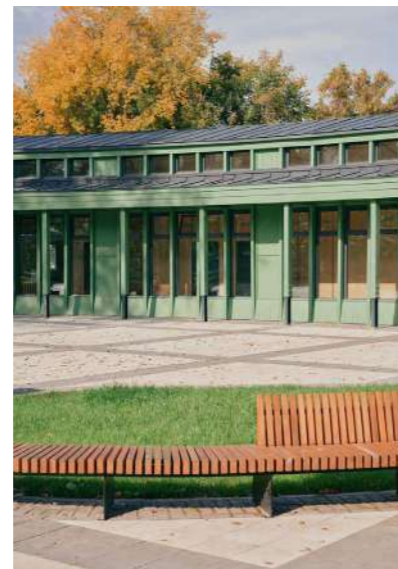
Элементы несущего каркаса открыты и выполняют в том числе декоративную функцию, формируют ритмичную пластику фасадов
