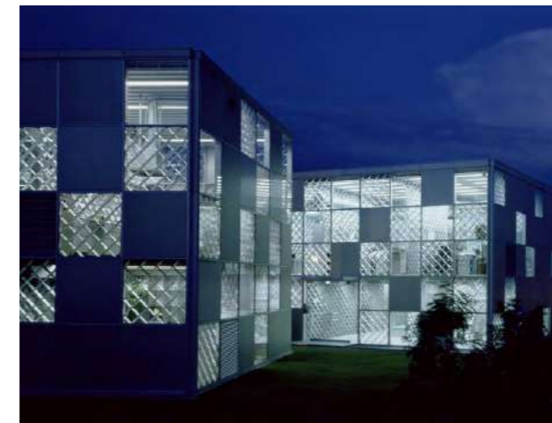
Комплекс Ecoms House, 2004. В этом проекте архитектор хотел показать потенциал алюминия как строительного материала в строительстве сборных домов
