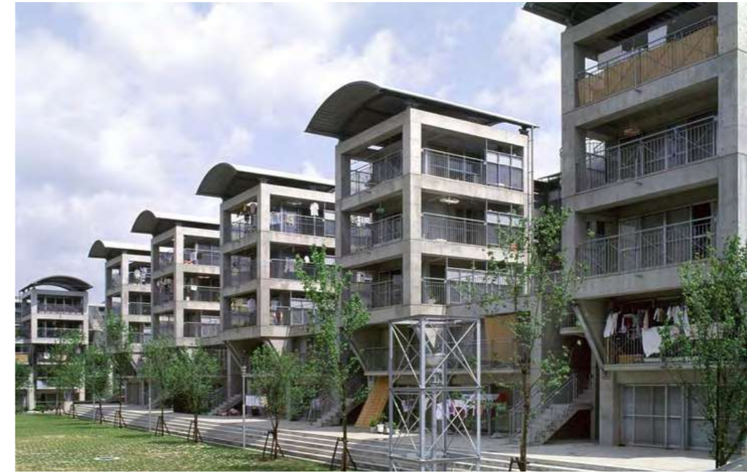
Проект социального жилья Hotakubo Housing. 1991. Комплекс состоит из 16 отдельных блоков, в которых в совокупности находится 110 домов с террасами. Эти блоки окружают обсаженную деревьями площадь в центре, куда можно попасть только изнутри
