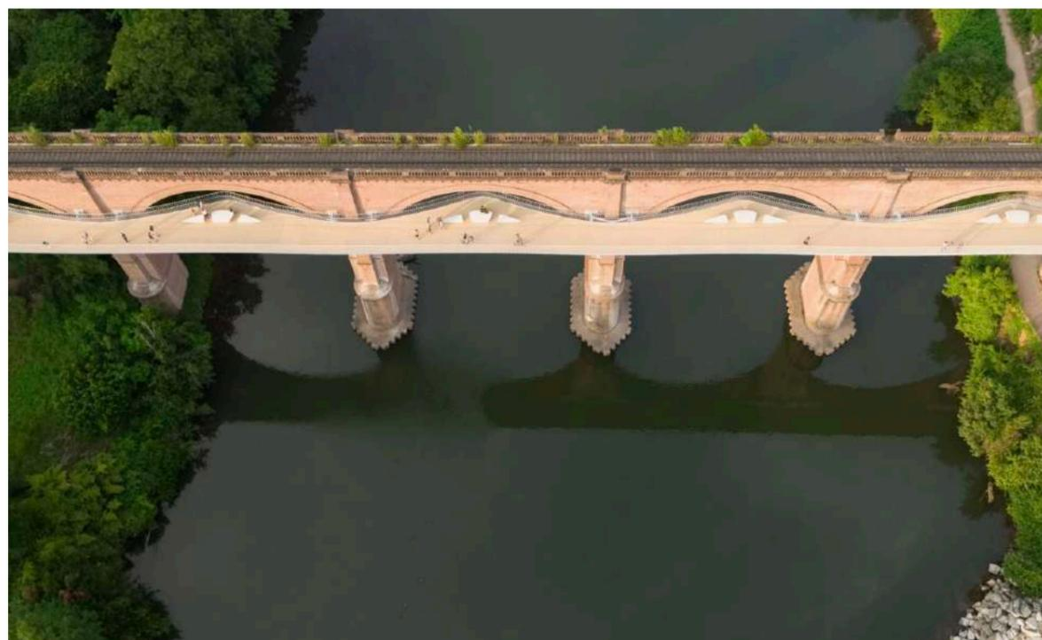
Бельгийская студия Ney and Partners спроектировала пешеходный мост в Альби – он построен вдоль действующего железнодорожного виадука XIX века шириной 4,7 метра и представляет собой волнистую конструкцию со смотровыми точками между 7,5-метровыми арками исторического сооружения. Мост призван обеспечить связь между центром города Альби и районами через реку Тарн.
