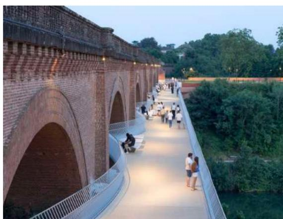
Конструкция изготовлена из стали и крепится к виадуку с помощью двухшарнирных стальных кронштейнов, которые компенсируют нагрузки, вызванные тепловым расширением. На выступах под арками архитекторы установили видовые скамейки, которые спланированы таким образом, чтобы находиться в тени.
