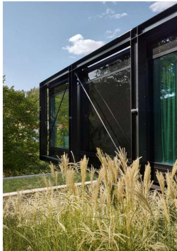
Конструктивное устройство дома довольно неожиданно и инновационно, так как использовать традиционные методы строительства в данном случае не позволял рельеф. Расстояние между бетонными пилонами составляет 18 метров, а общая длина дома достигает 28 м при ширине 8 м. Перекрыть безопорные пролеты помогают стальные балки профиля НЕВ 300. Все остальные несущие элементы, такие, например, как стойки окон и балки перекрытий, выполнены из более тонкого стального профиля IPE 160.
